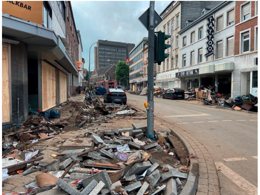
Die Wassermassen richteten in vielen nordrheinischen Städten erhebliche Schäden an.
