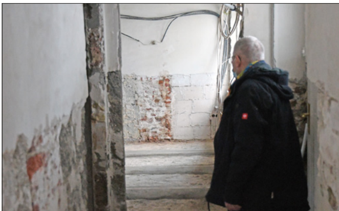
Ein Bild der Verwüstung: Viele Praxen in Nordrhein sind infolge der Hochwasserschäden stark sanierungsbedürftig. Die Reparaturarbeiten ziehen sich bis heute hin.
